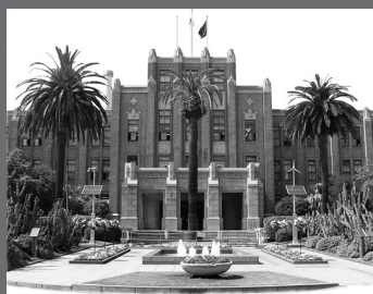
宮崎県庁本館
